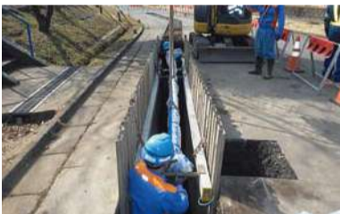
耐震管の埋設
