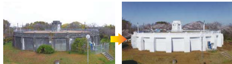
浄化施設の壁面（施行前） 壁面の耐震化（施行後）
