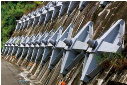
地滑り対応アンカー工（鴨川市）
